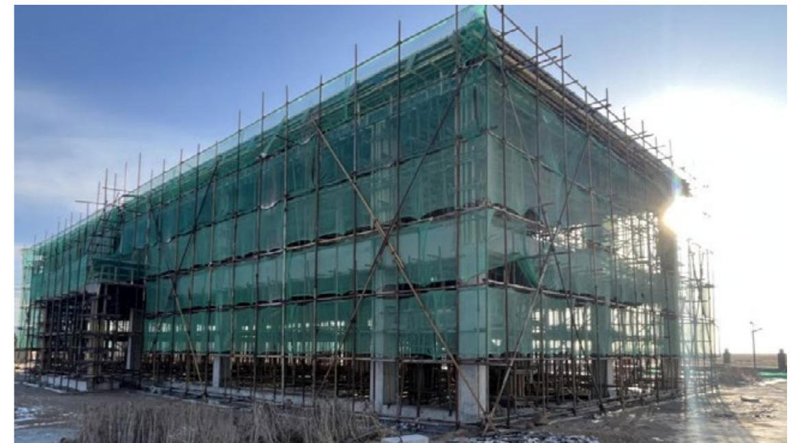
苏尼特右旗“蒙医医院”施工现场
